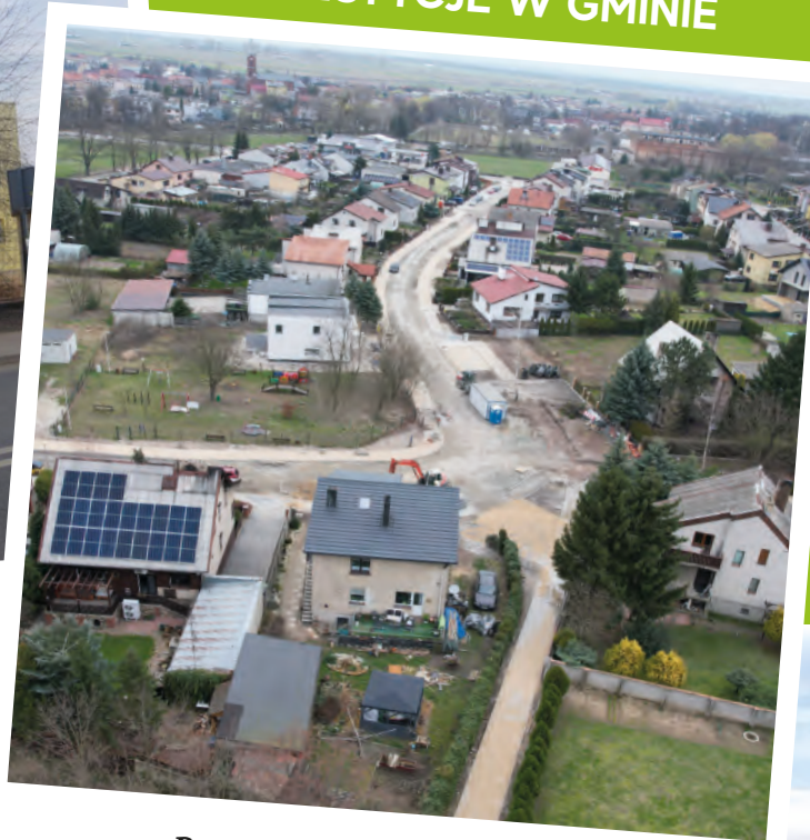
Budowa ulic na osiedlu Przylesie
